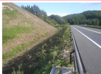
⑦施工：樋下建設
